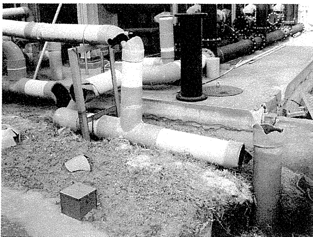
取水系統配管の損壊 震災発生時に海水が噴き出した
